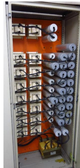
(a) Beispielhafte Darstellung eines Netzes mit einer verdrosselten Kompensation (b) Foto einer 400 V verdrosselte Kompensation
