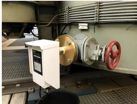
Abbildung 6. Beispielhafte Installation eines Gerätes M1 (MHT410, VAISALA)
