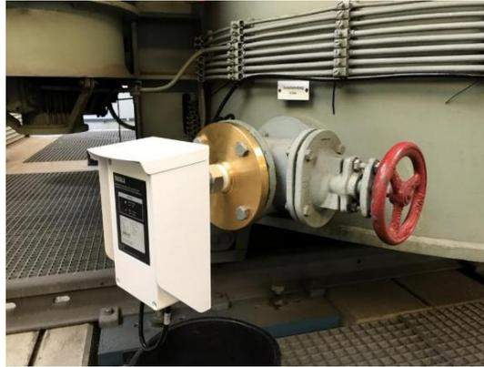
Abbildung 6. Beispielhafte Installation eines Gerätes M1 (MHT410, VAISALA)
