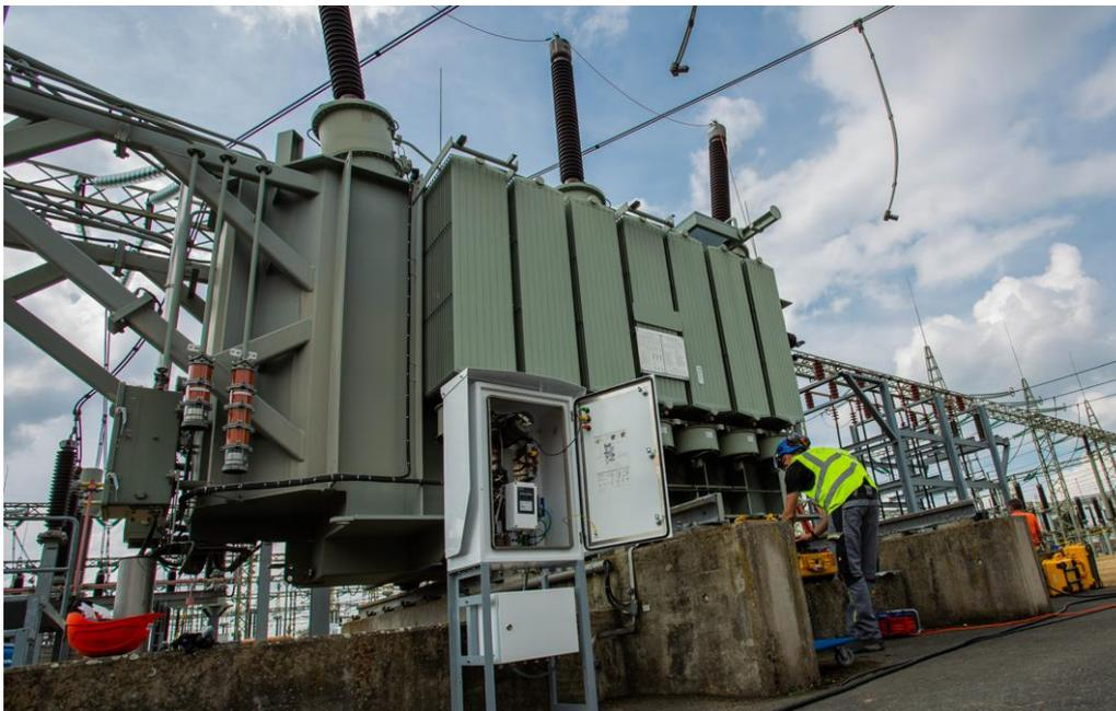
Abbildung 7. Beispielhafte Installation eines Gerätes M7 (OPT100, VAISALA)
