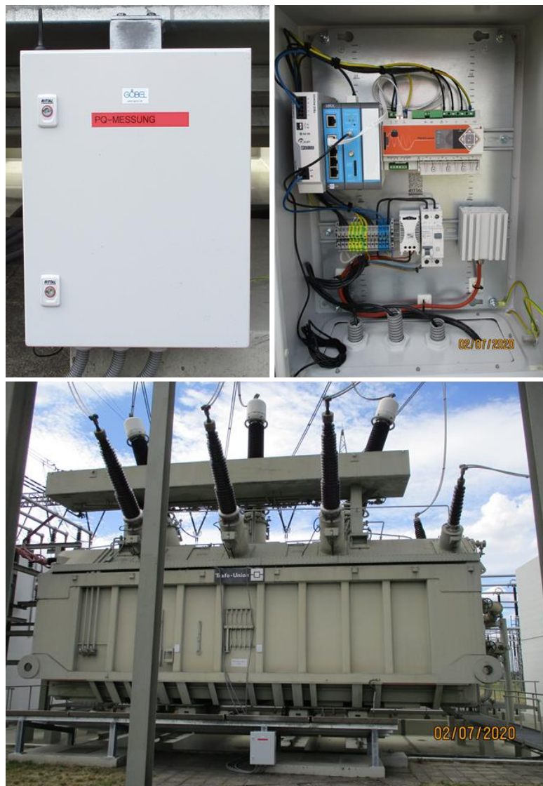
Abbildung 7. Vorübergehende Installation eines Durchführungsteilers an den 220 kV-Durchführungen eines Transformators mit der Unterbringung des Messsystems in einem aufgestellten Schaltschrank
