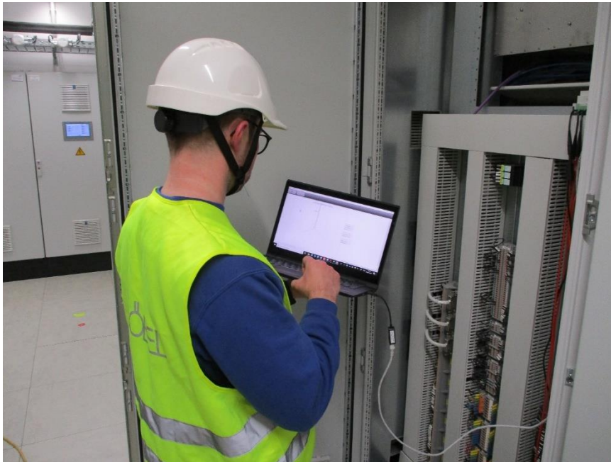
Abbildung 1. Vor-Ort-Verifikation der Genauigkeit von festinstallierten PQ-Messgeräten im Umspannwerk
